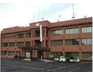
【鹿児島市役所 松元支所】
