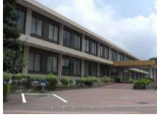
【鹿児島県民総合保健センター】
