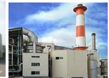
【NRK Clean Center】
