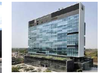
【インド・リッツカールトンホテル】
