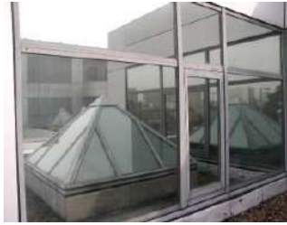
【札幌市厚別区役所区長室】
