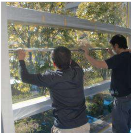
スポンジバー工法
