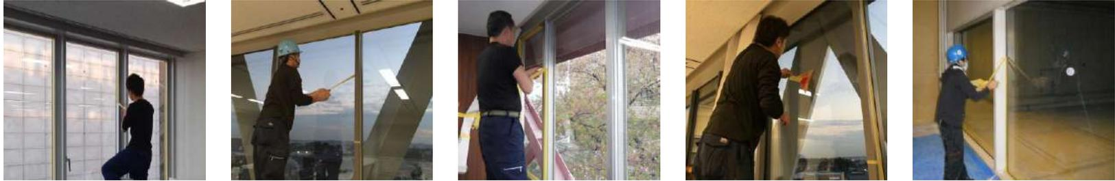
コーティング後、約1時間を目安に指触乾燥（マスキングテープに付いた液を触り指に付かない）を確認し、マスキングテープを両手で1辺ずつ丁寧に剥がします。
