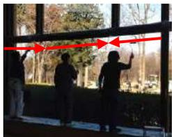
上部両側より中心へ向かい、軽く（30%）横入れをし繋ぎ目を越えた所で、ローラーを止めず仕上げ時と同じようにぬめます。
